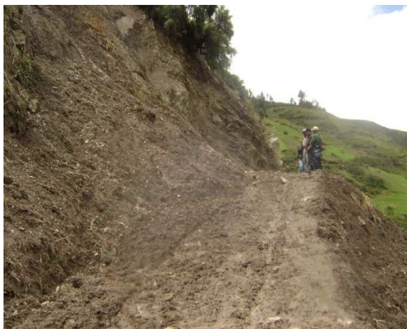
CARRETERA PAMPAS- MANTACRA
